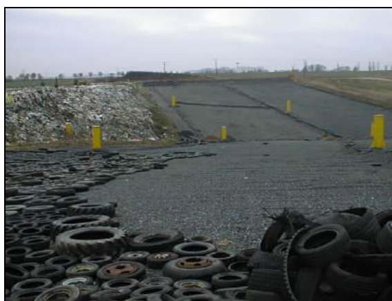
Obr. 4 Druhá etapa ze založenými šachtami odplynění
