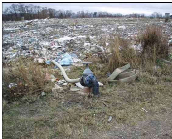
Obr. 2 Celkový pohled na povrch skládky
