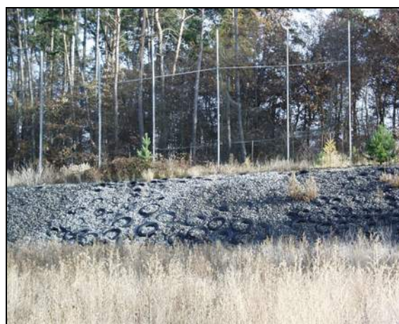
Obr. 4 Konstrukce hráze, oplocení, síť proti úletům
