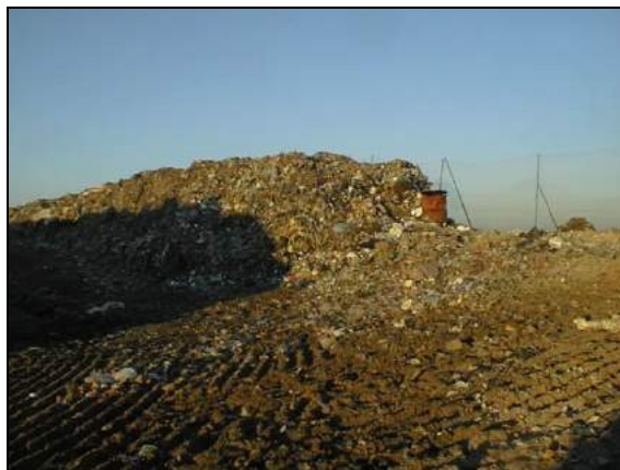
Obr. 4 Úprava povrchu složiště, studna odplynění
