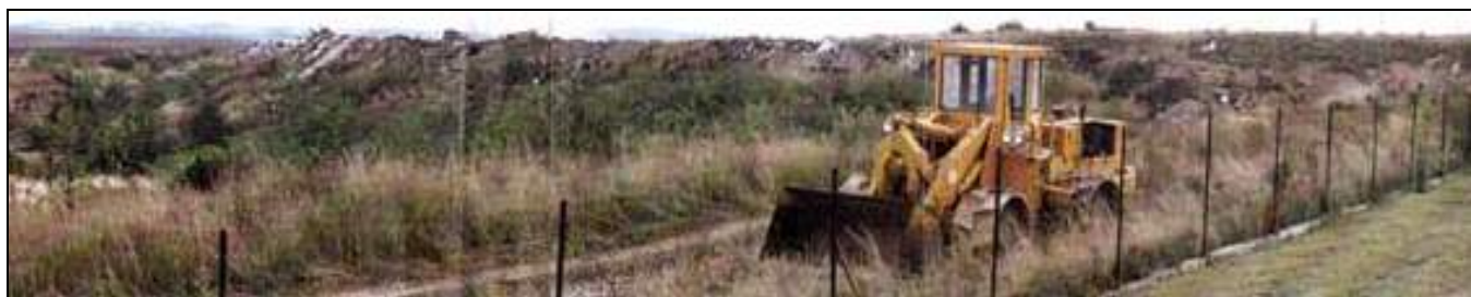
Obr. 3 Celkový pohled od administrativní budovy
