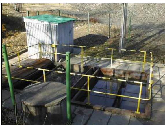
Obr. 3 ČOV obce Lhoty u říčky Litávky, jz. okraj haldy
