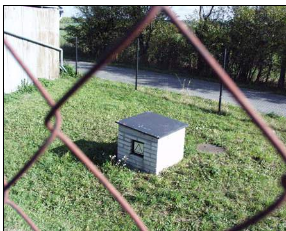
Obr. 3 Jímka – podzemní objekt s šachtovým vstupem
