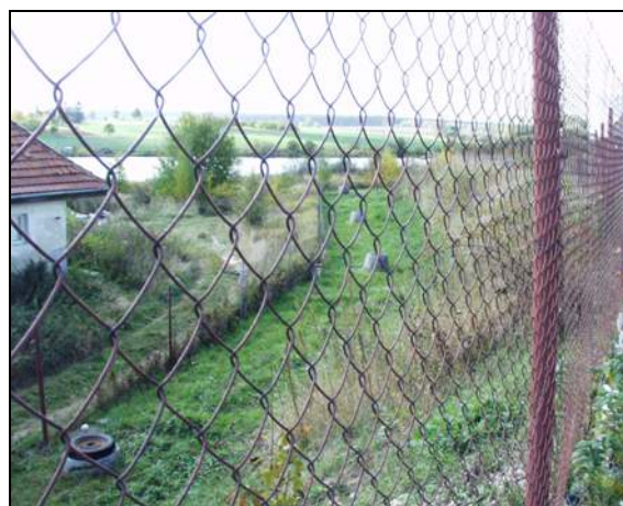
Obr. 4 Hráz, oplocení, šachty na svodném potrubí
